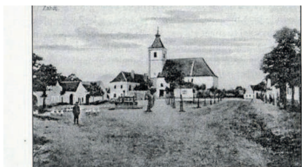
Zahájí na počátku 20. století. Střecha kostela již byla tašková, zatímco stanová střecha věže dosud krytá šindelem. Před kostelem ještě stojí pívodní ohradní zeď hřbitova a márnice. Na návsi je obecní studna, u níž byl až do roku 1954 obyčejný okov. Stará pohlednice (vydal Fr. Čamra, Zahájí).
